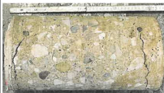
Foto 6: ... Ansicht des gewonnenen Bohrkerns 1.
