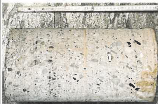
Foto 8: ... Ansicht des gewonnenen Bohrkerns 2.
