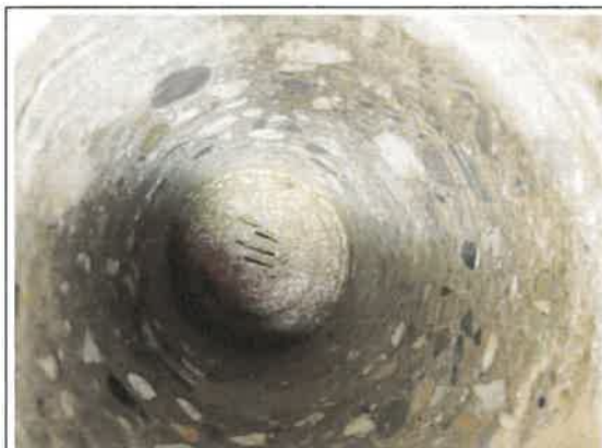
Foto 5: Blick in die durchkernte Außenwand und ...
