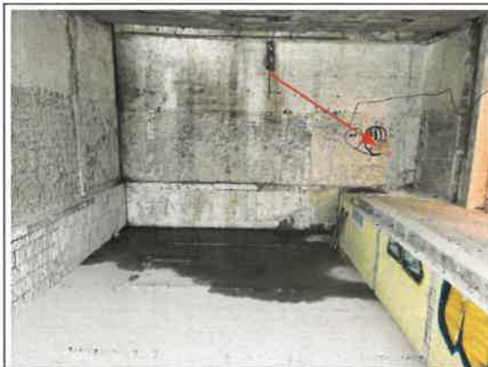
Foto 1: Ansicht des ehem. Schwimmbeckens im Ostteil des Anbaus vor der zu betrachtenden Keller- ...
