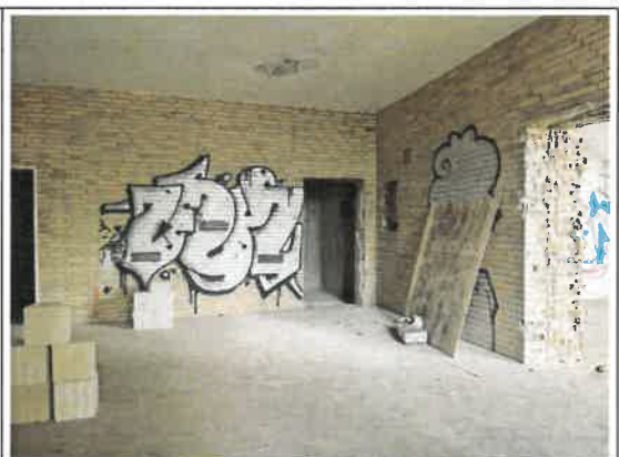
Foto 4: ... an dem sich auch der Zugang zur westlich anschließenden Turnhalle befindet (rechts im Bild).
